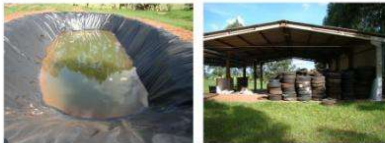
Figura 6: À esquerda acima lagoa de depósito do chorume a ser produzido na nova vala do aterro sanitário, à direita acima depósito de pneus no barracão do aterro sanitário municipal.
